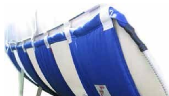
TERMOCOPERTA INSTALATA PE REZERVOR
