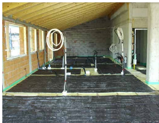
SISTEM DE INCALZIRE MULTISTRAT – EXEMPLU DE MONTAJ
